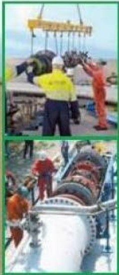
ISPEZIONE DI INTEGRITÀ PIPELINE INSPECTION
