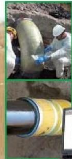
RIPARAZIONE RINFORZO PIPELINE REPAIR
